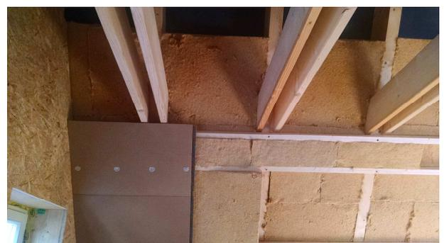
der Innenausbau mit Holzfaserdämmung und Holzfaserplatten
