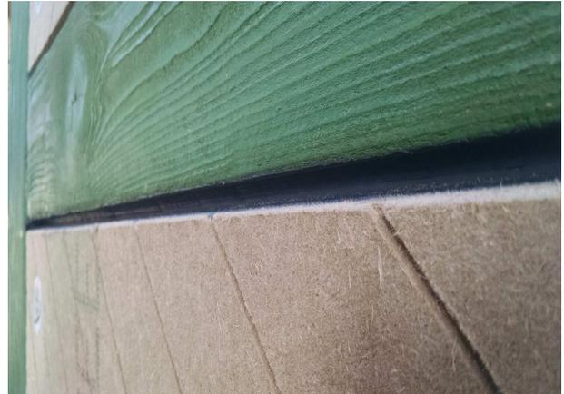
die Ränder werden ausgestopft und mit Spezialkleber abgedichtet
