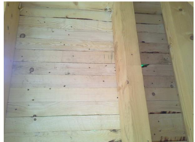
komplette Innenansicht mit der Sparschalung , rechts die Schrauben die Verschraubung von innen
