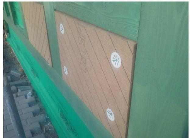
vor dem Sichtfachwerk wird eine Schalungsbahn auf die Sparschalung gebracht, die Seiten werden mit Klebeband abgedichtet
