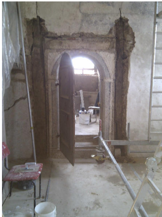
Ansicht nach dem teilweisen Freilegen der Stiele auf Innenseite
