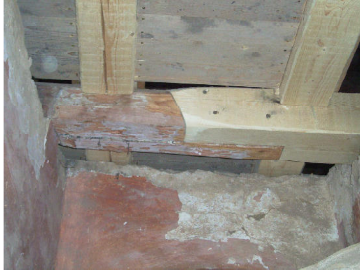
Angeblatteter Unterzug unter den Balken
