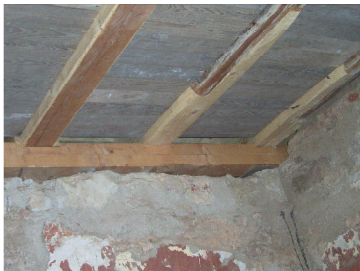
Teilweise wurde die Mauerlatte auch zweiteilig eingebaut
