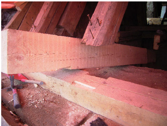
Verkämmungen an den Mauerlatten wurden neu hergestellt
