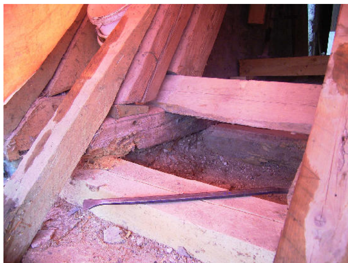
Sparren zu kurz abgeschnitten, kein Zapfen mehr vorhanden
