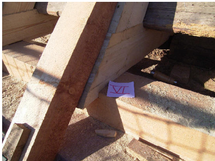
Eingebaute äußere Mauerlatte
