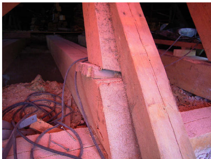
Keine Verzapfung und eingeschlagene Keile zur Kraftübertragung
