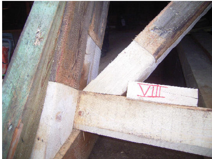
1990 zu kurz abgeschnittener Sparren
