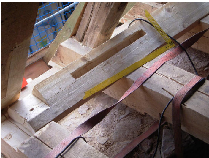
Keilswelle mit langem Zapfenloch für Schleifzapfen
