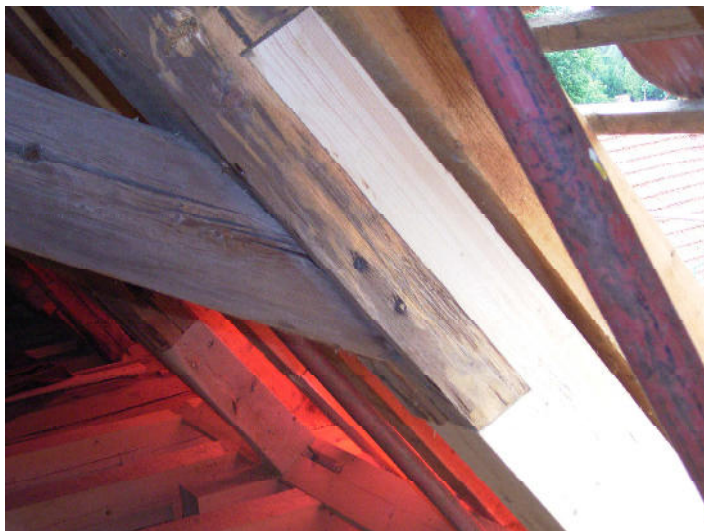
Stuhlsäule, die vorher mit einer Stahlschelle verbunden war
