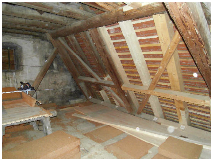
Einbau von Holzfaserdämmung zwischen Fehlboden und Rauhspond – Fußboden
