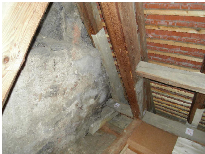
Sparren an der Giebelwand
