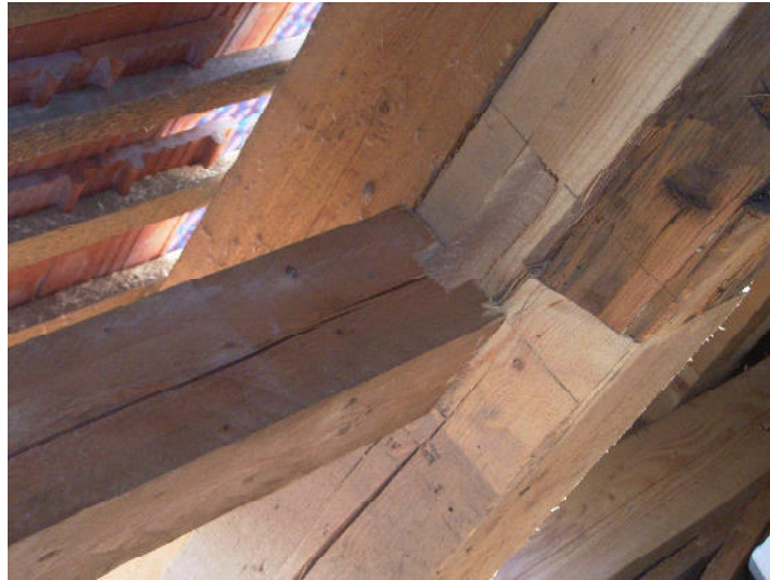
Falscher Zapfen an angeblatteter Stuhlsäule
