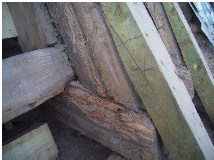
Stuhlschwelle ohne größere Schäden
