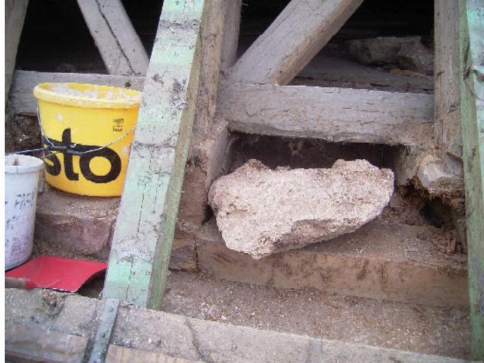
Vordere Mauerlatte wurde 1990 ohne Verkämmungen erneuert.
