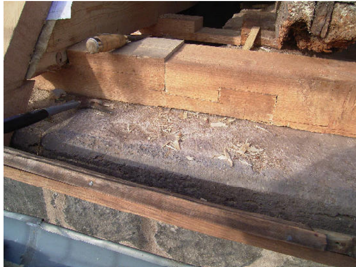
Neue Mauerlatte mit Schwellenschloss
