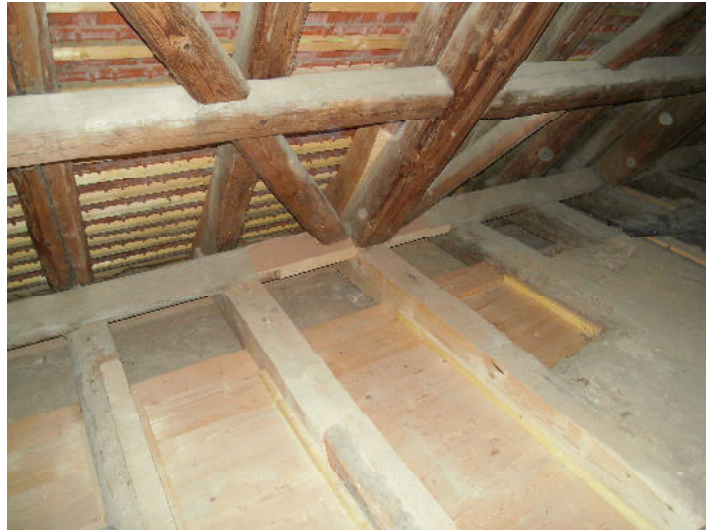
Neue Deckenbalken mit eingebautem Fehlboden
