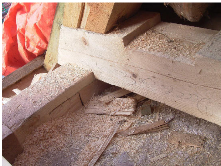
Schwellenschlösser an den äußeren Mauerlatten wurden nachgerüstet
