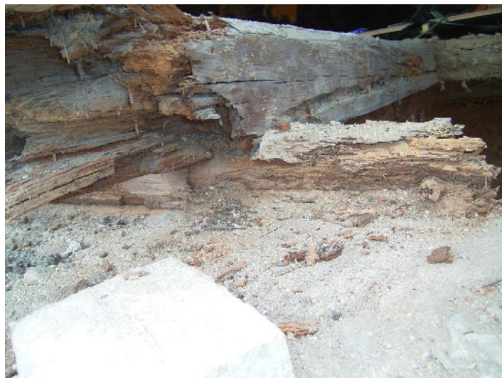
Innere Mauerlatte Nordseite
