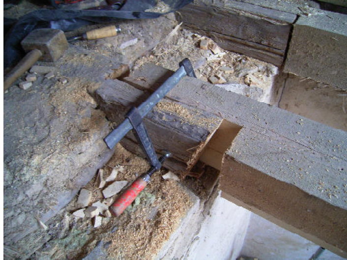
Balkenstoß vor dem Einsetzen der Ergänzungshölzer
