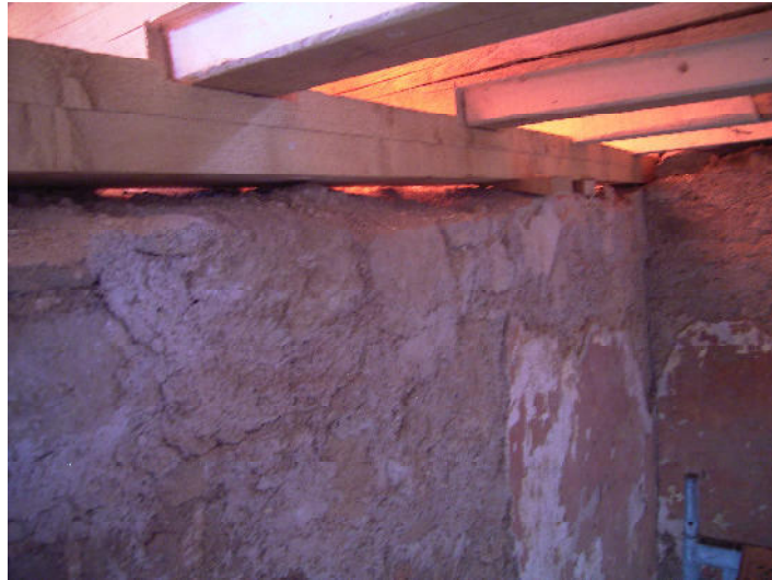
Neue innere Mauerlatte
