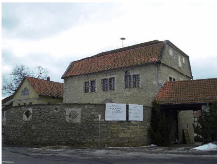
Außenansicht – Nord – West
