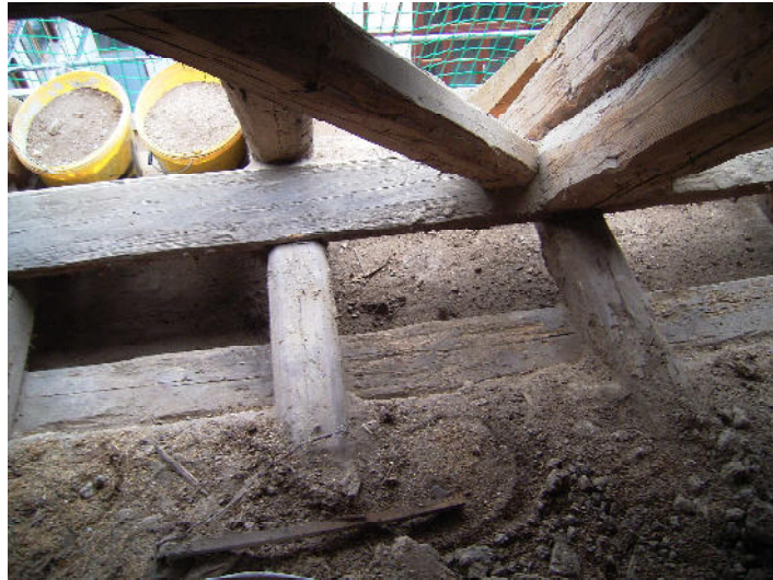
Bestand Balkenköpfe von der Innenseite
