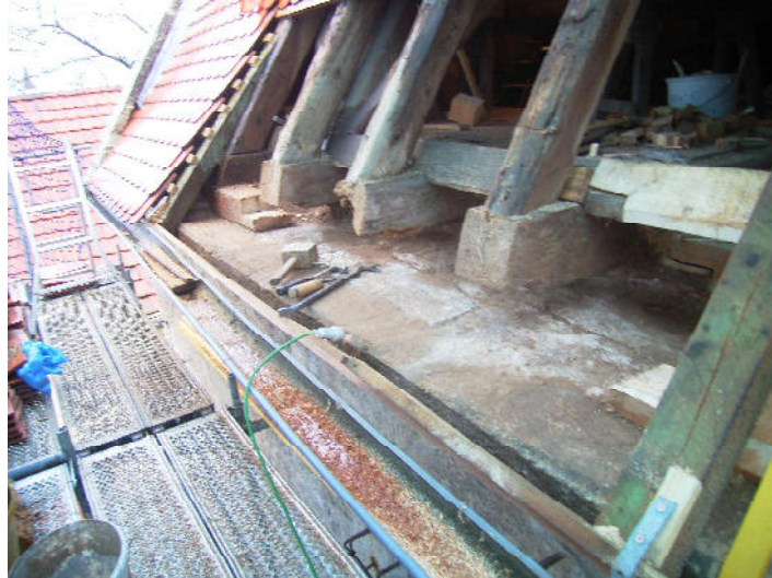
Die äußere Mauerlatte musste ausgebaut werden, um neue Verkämmungen anzuarbeiten.
