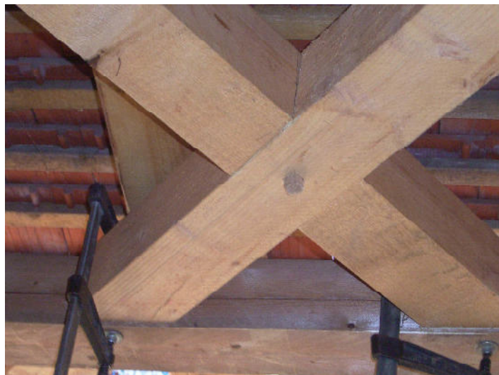
Neu eingebauter Windverband
