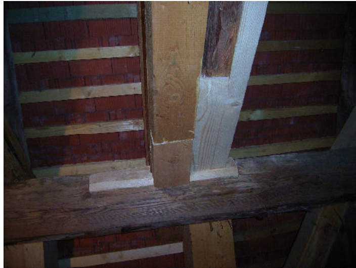
Bohlenergänzung am Rähm
