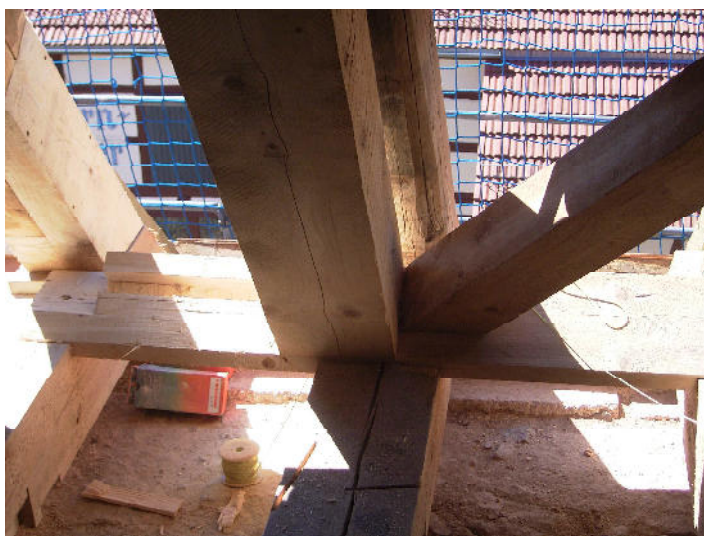
Neu eingebaute Stuhlsäule und Windverband
