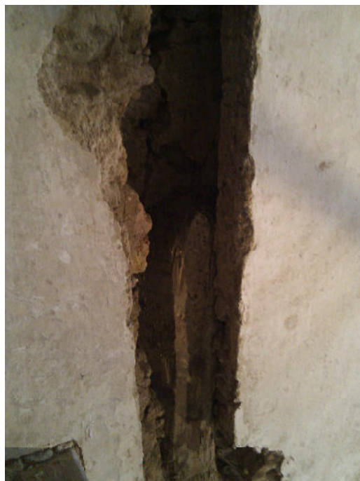
Linker Stiel im oberen Bereich
