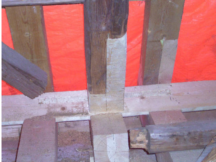
Angeblattete Stuhlsäule und neue Stuhlschwelle
