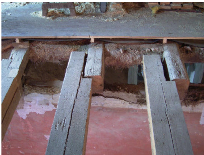
Balkenstoß über Raum 1.9 von der Seite
