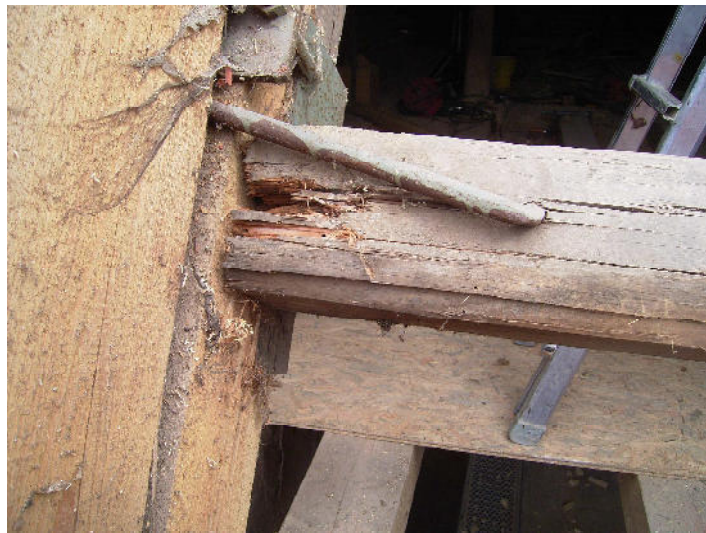
Verbindungen wurden mit Bauklammern hergestellt
