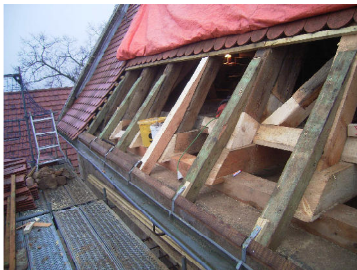
Für die Verkämmung an den Balkenköpfen wurde ein neues Vorholz an den Kopf angesetzt
