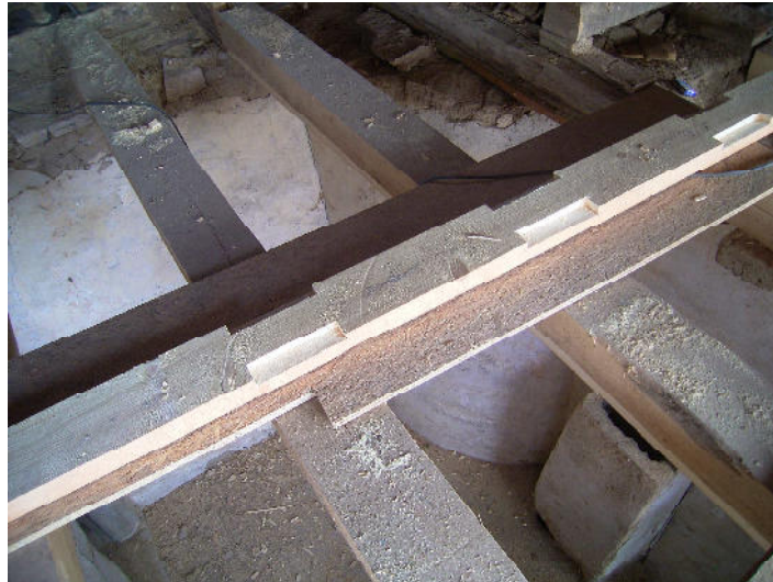
Neue Mauerlatte mit entsprechenden Verkämmungen
