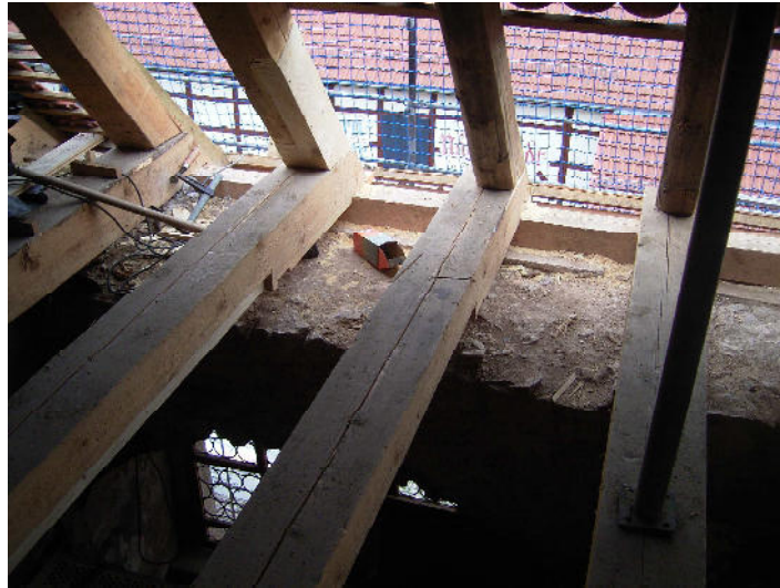
Wiedereingebaute Deckenbalken an der Südseite mit den Nuten auf der Unterseite
