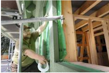
Zimmermann Rocco Smars befestigt eine Dampfsperre an der Schalung der Außenwand. Foto: Jens König
